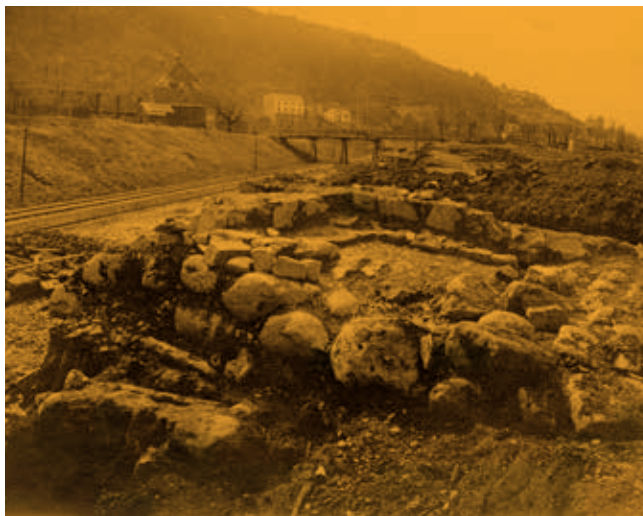
Utgravning i forbindelse med jernbanebygging på 1890-tallet.
